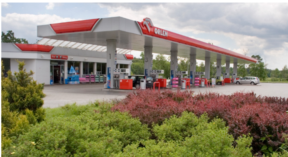
Miejsce Obsługi Podróżnych przy A4 Katowice-Kraków
