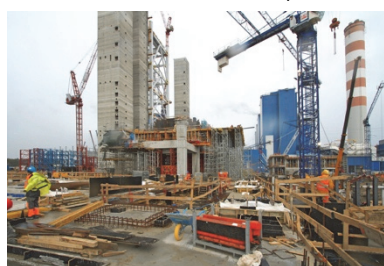
Budowa bloków Elektrowni Opole
