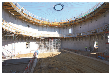
Budowa Hali dla CMC Poland
