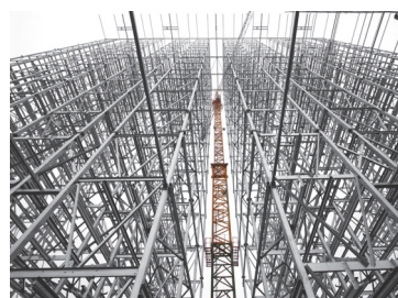
Budowa magazynu dla Amica S.A.
