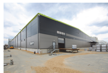
Budowa Centrum Innowacji, Badań i Rozwoju Tymbark MWS
