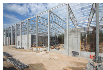
Hala Magazynowa Paliw Alternatywnych dla Lafarge Cement S.A.
