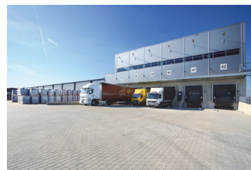
Rozbudowa Centrum Logistycznego dla ILS Sp. z o.o.
