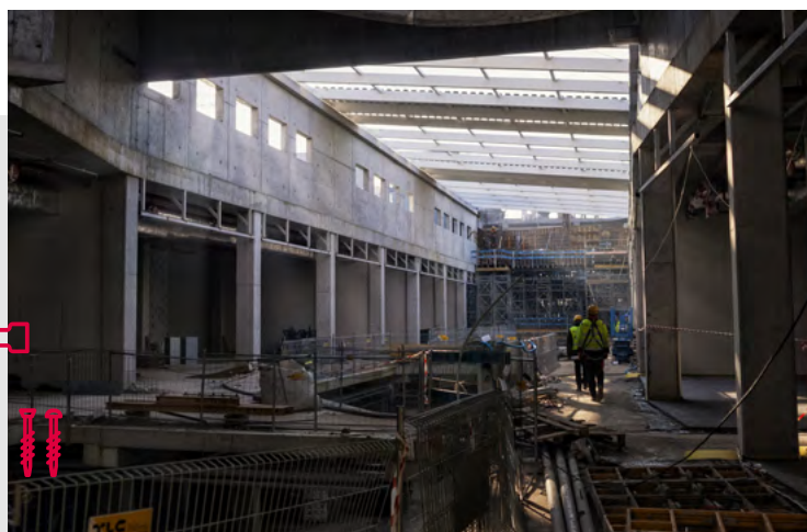
Budowa Libero, Katowice
