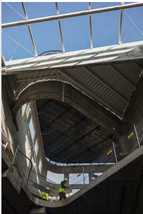
Budowa Galerii Młociny, Warszawa
