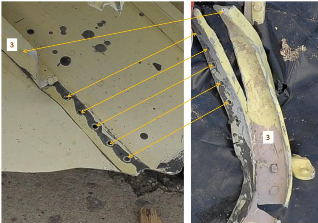
Detal wyrwania podłużnicy nr 3 z poszycia spodniego i zagięcia jej do dołu .
