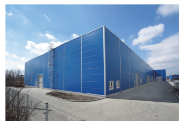
Budowa hali magazynowej dla Asetino
