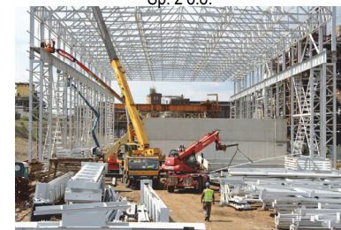
Budowa Hali Namiarowni Wsadu dla ZGH Bolesław S.A.
