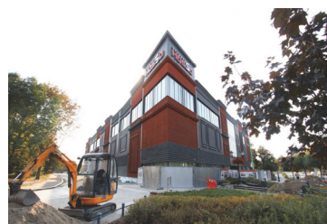
Budowa Galerii Handlowej w Gubinie
