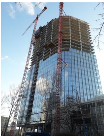
Budynek biurowo – mieszkalny MENNICA
