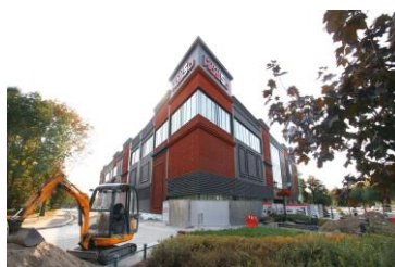
Budowa Galerii Handlowej w Gubinie
