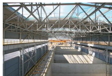
Budowa Hali Namiarowni Wsadu w ZGH Bolesław S.A.
