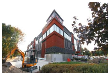
Budowa Galerii Handlowej w Gubinie
