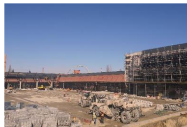
Budowa Centrum Handlowego dla Tkalnia Sp. z o.o.
