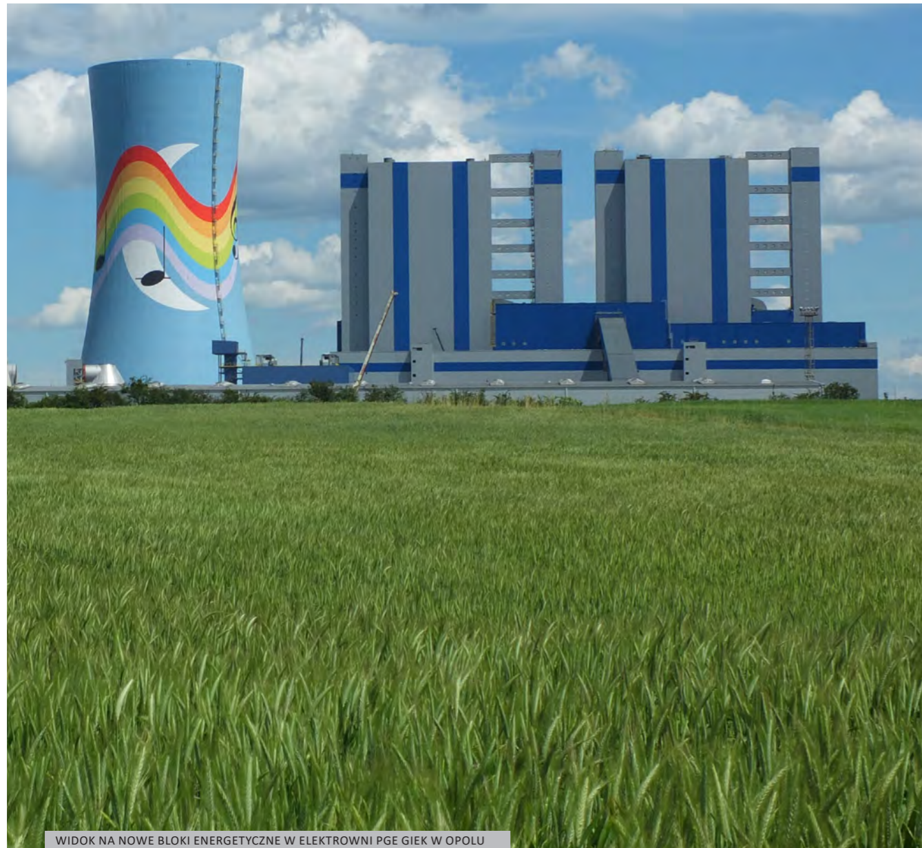
WIDOK NA NOWE BLOKI ENERGETYCZNE W ELEKTROWNI PGE GIEK W OPOLU
