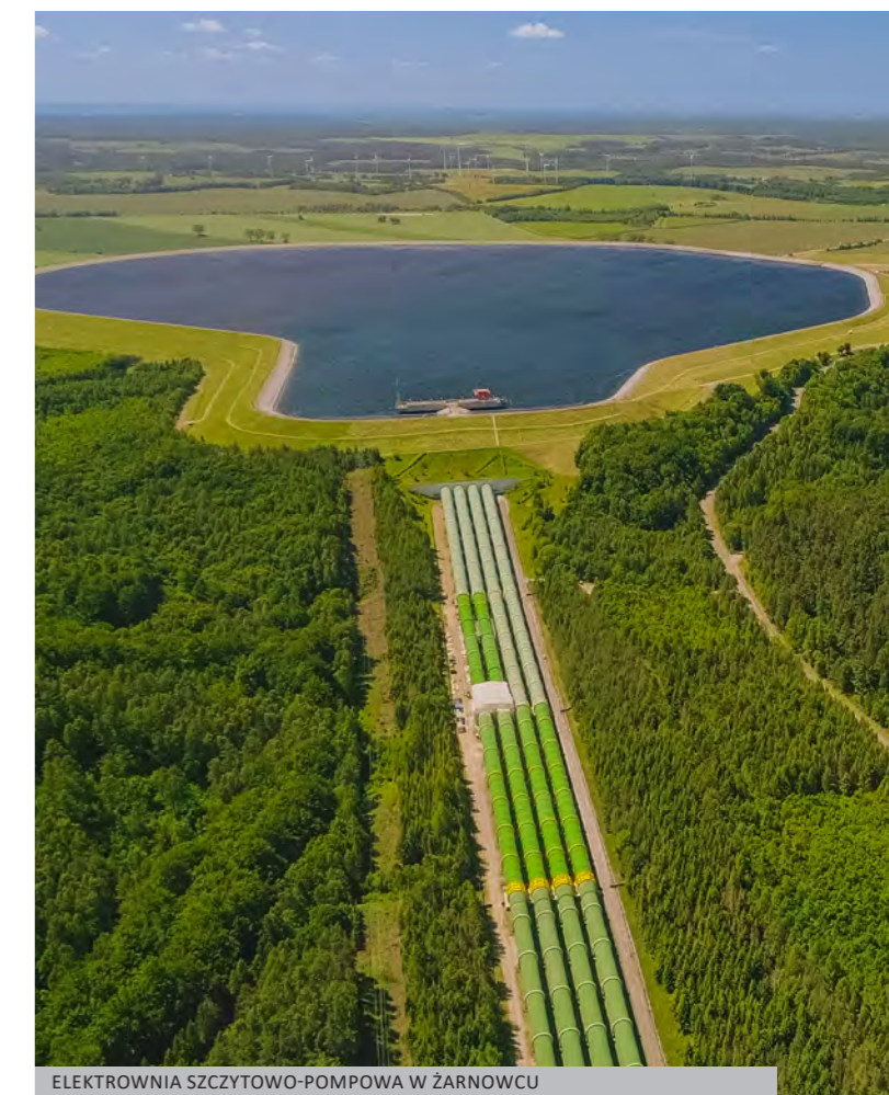
ELEKTROWNIA SZCZYTOWO-POMPOWA W ŻARNOWCU
