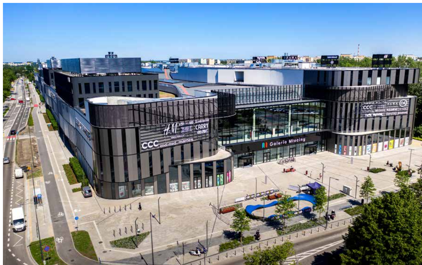
CENTRUM HANDLOWO-USŁUGOWO-ROZRYWKOWE GALERIA MŁOCINY
