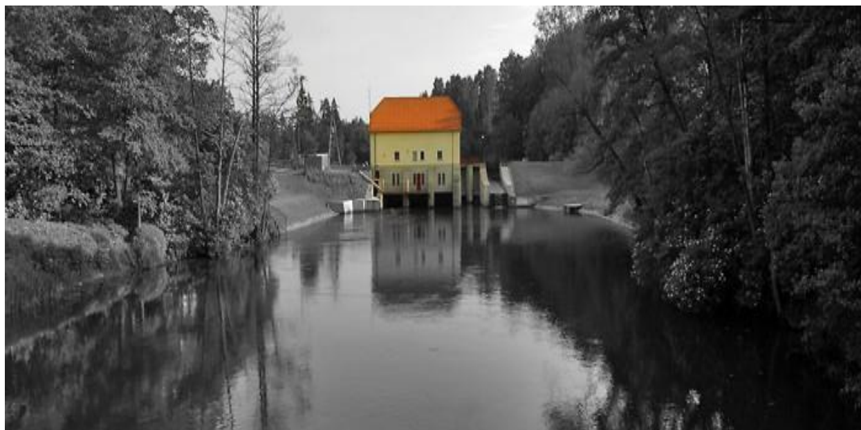
Elektrownia Wodna Łyna
