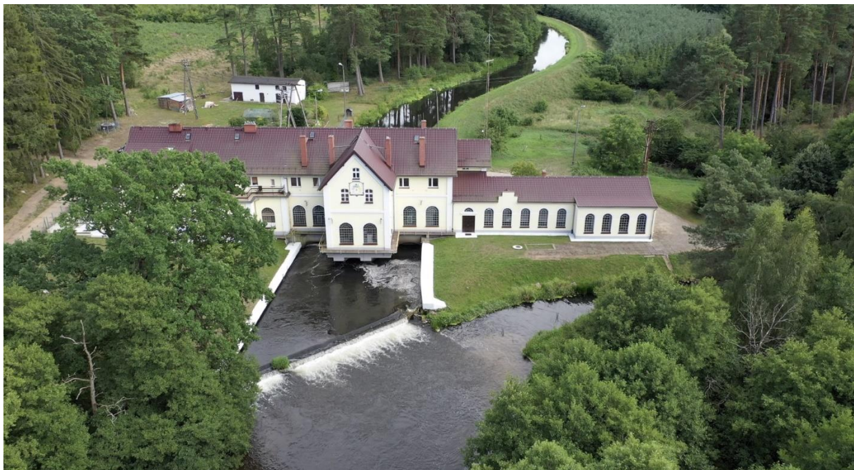
Elektrownia Wodna Żelkowo
