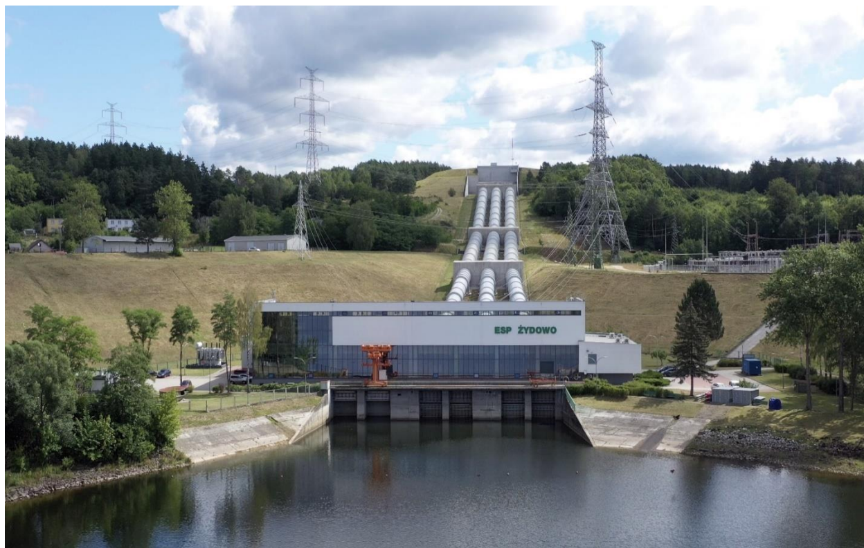
Elektrownia szczytowo-pompowa w Żydowie
