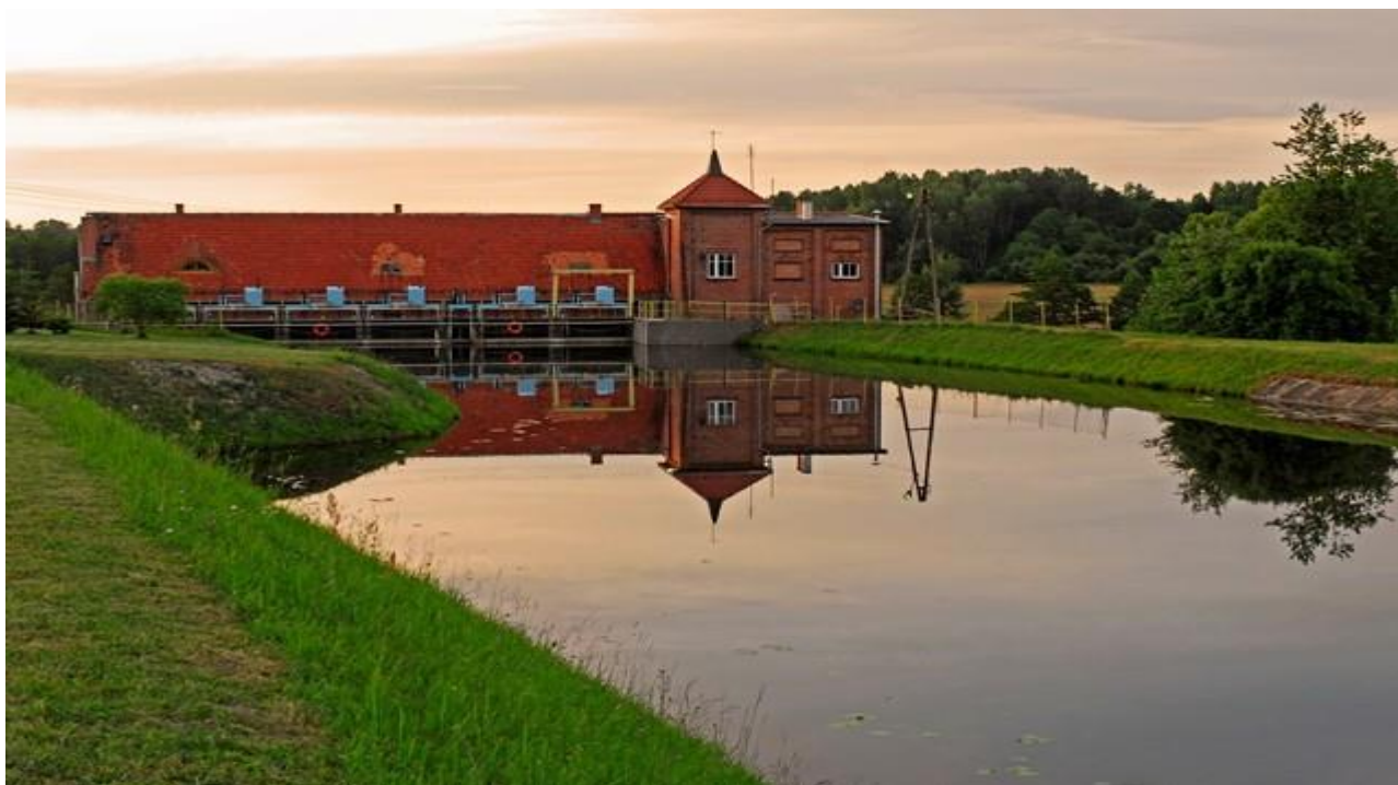
Elektrownia Wodna Pierzchały
