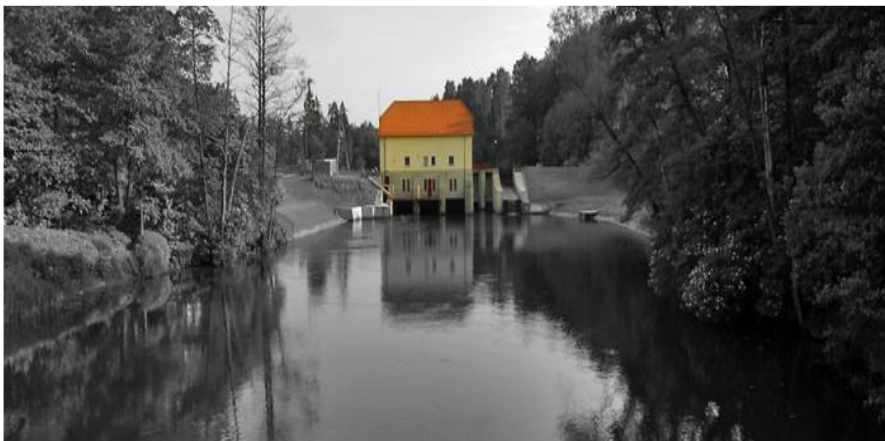
Elektrownia Wodna Łyna
