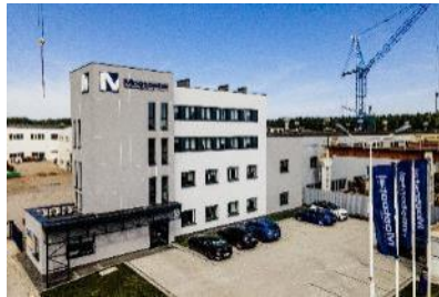
Siedziba Mostostal Kielce S.A.
