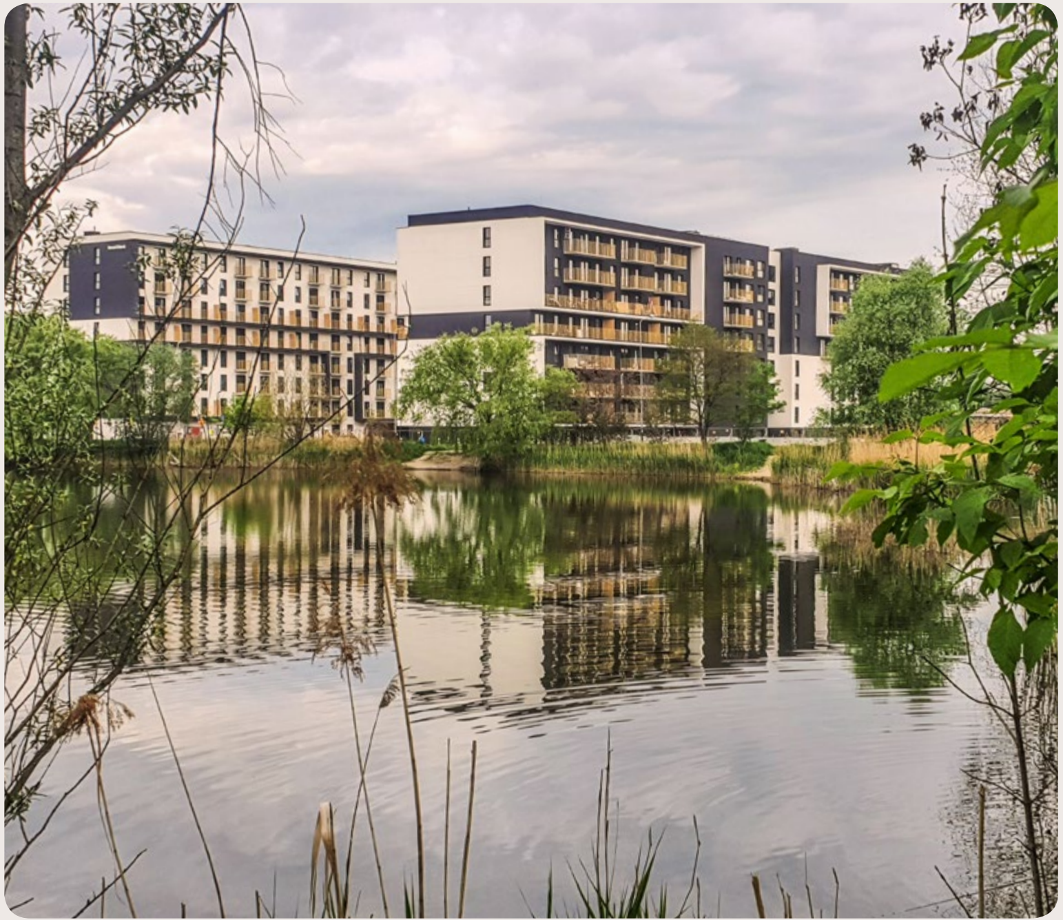
Budowa osiedla Bonarka Living w Krakowie
