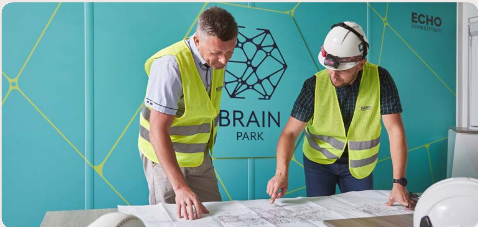
Fot. Biurowiec BrainPark w Krakowie w budowie
