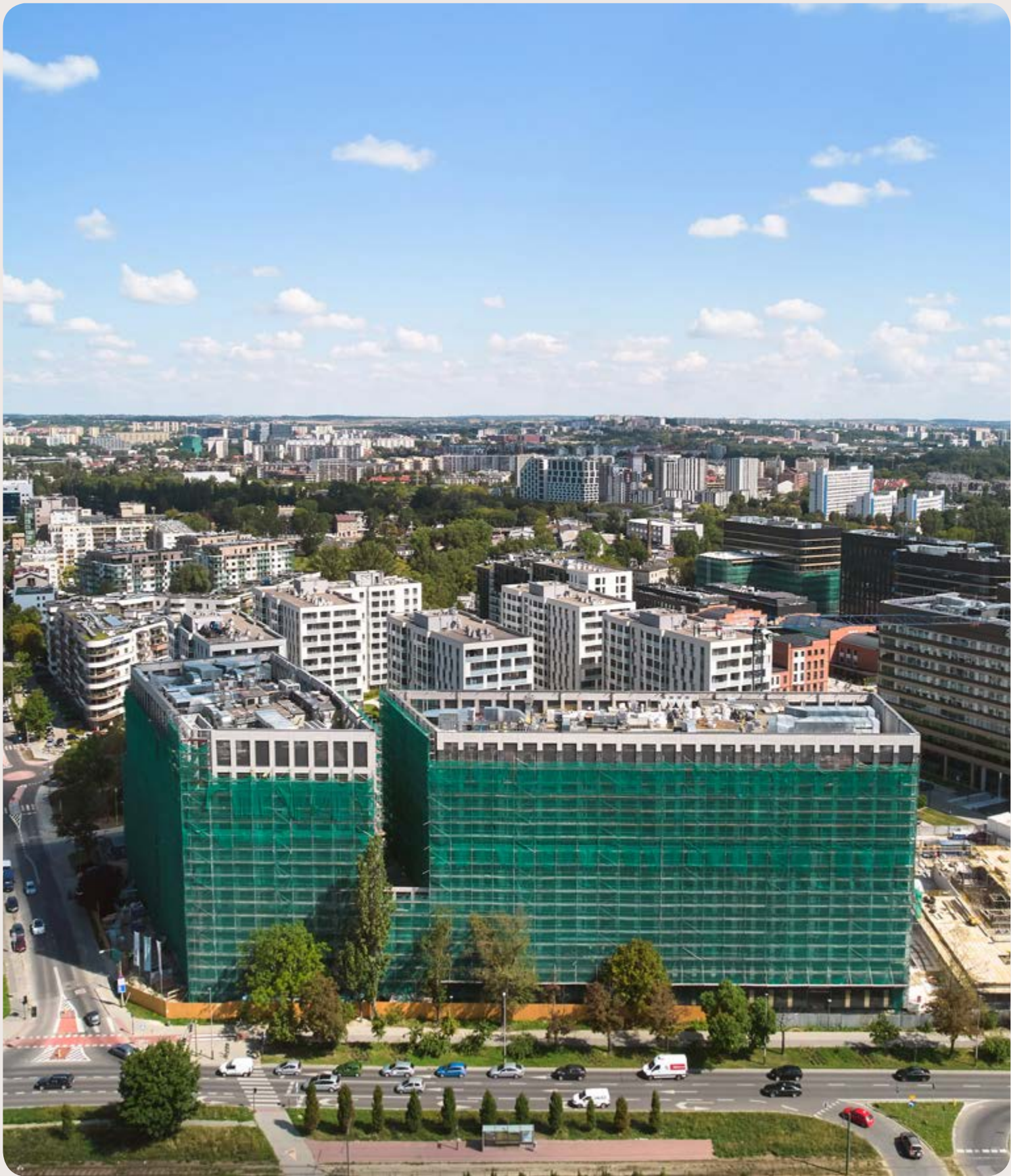
Fot. Biurowiec BrainPark w Krakowie w budowie
