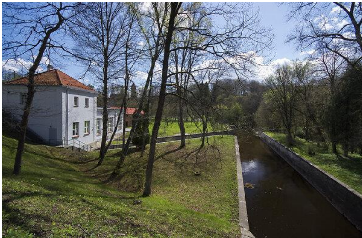
Elektrownia wodna Pieniężno
