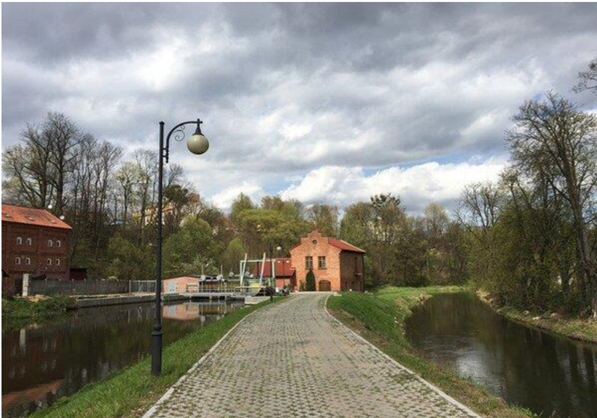
Elektrownia wodna Lidzbark
