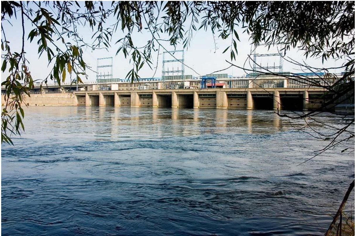
Elektrownia Wodna we Włocławku
