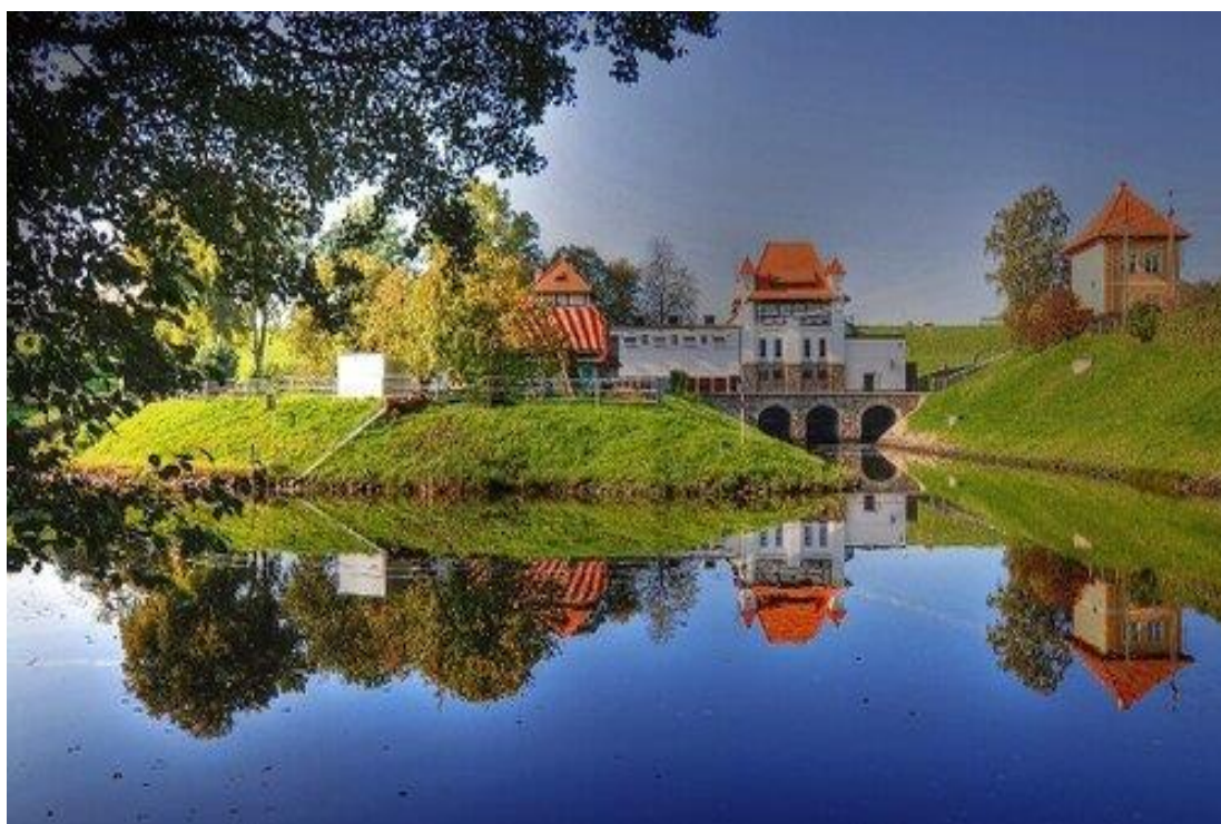
Elektrownia Wodna w Straszynie
