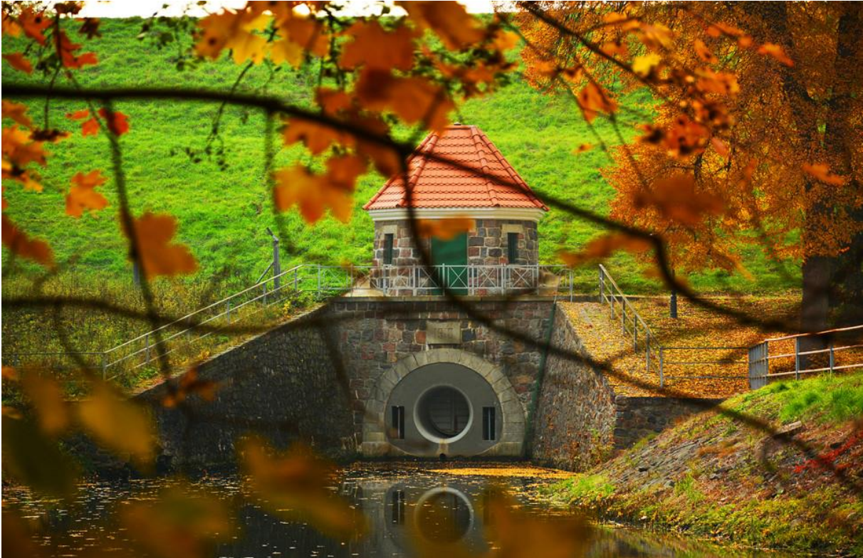
Elektrownia Wodna w Straszynie
