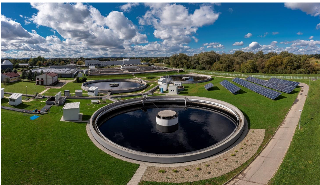
Rozbudowa i przebudowa oczyszczalni ścieków w Krośnicach
