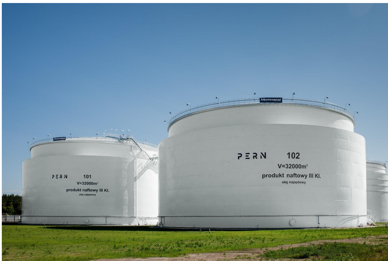
Zbiorniki magazynowe w Bazach Paliw
