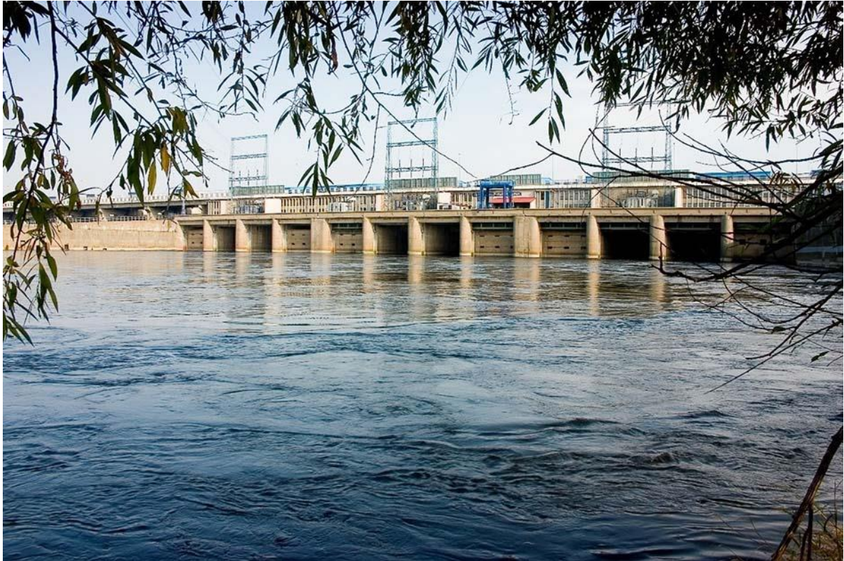
Elektrownia Wodna we Włocławku
