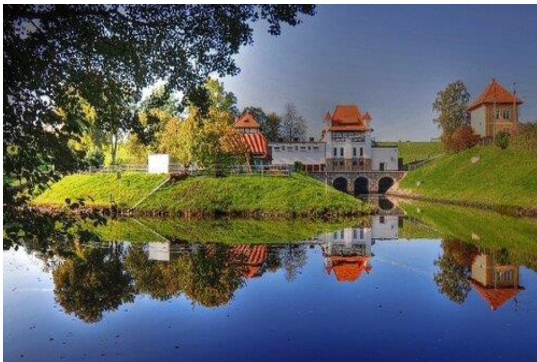
Elektrownia Wodna w Straszynie
