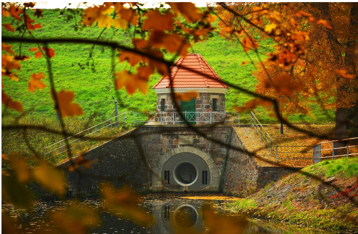
Elektrownia Wodna w Straszynie
