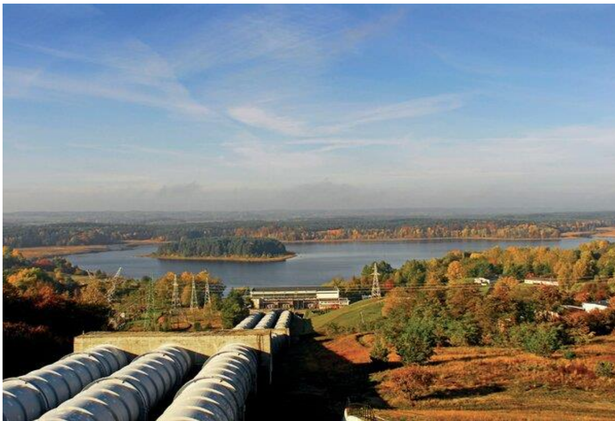
Elektrownia szczytowo-pompowa Żydowo
