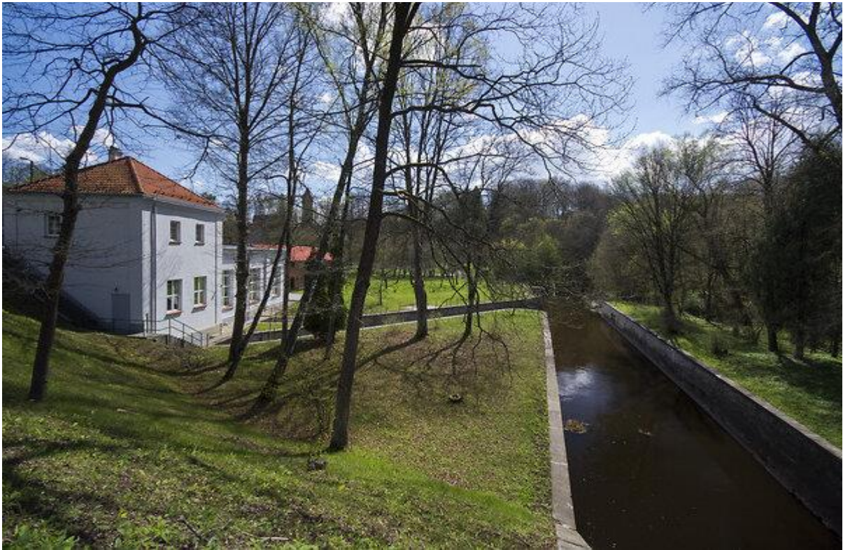
Elektrownia wodna Pieniężno
