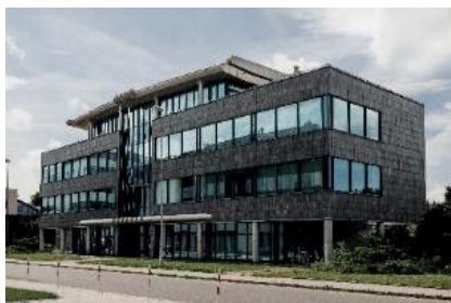
Siedziba AMK Kraków S.A.
