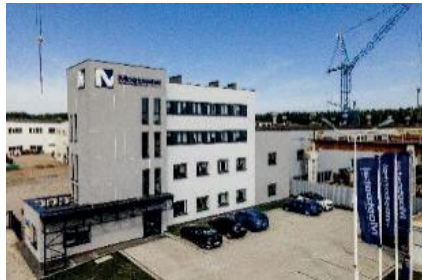
Siedziba Mostostal Kielce S.A.
