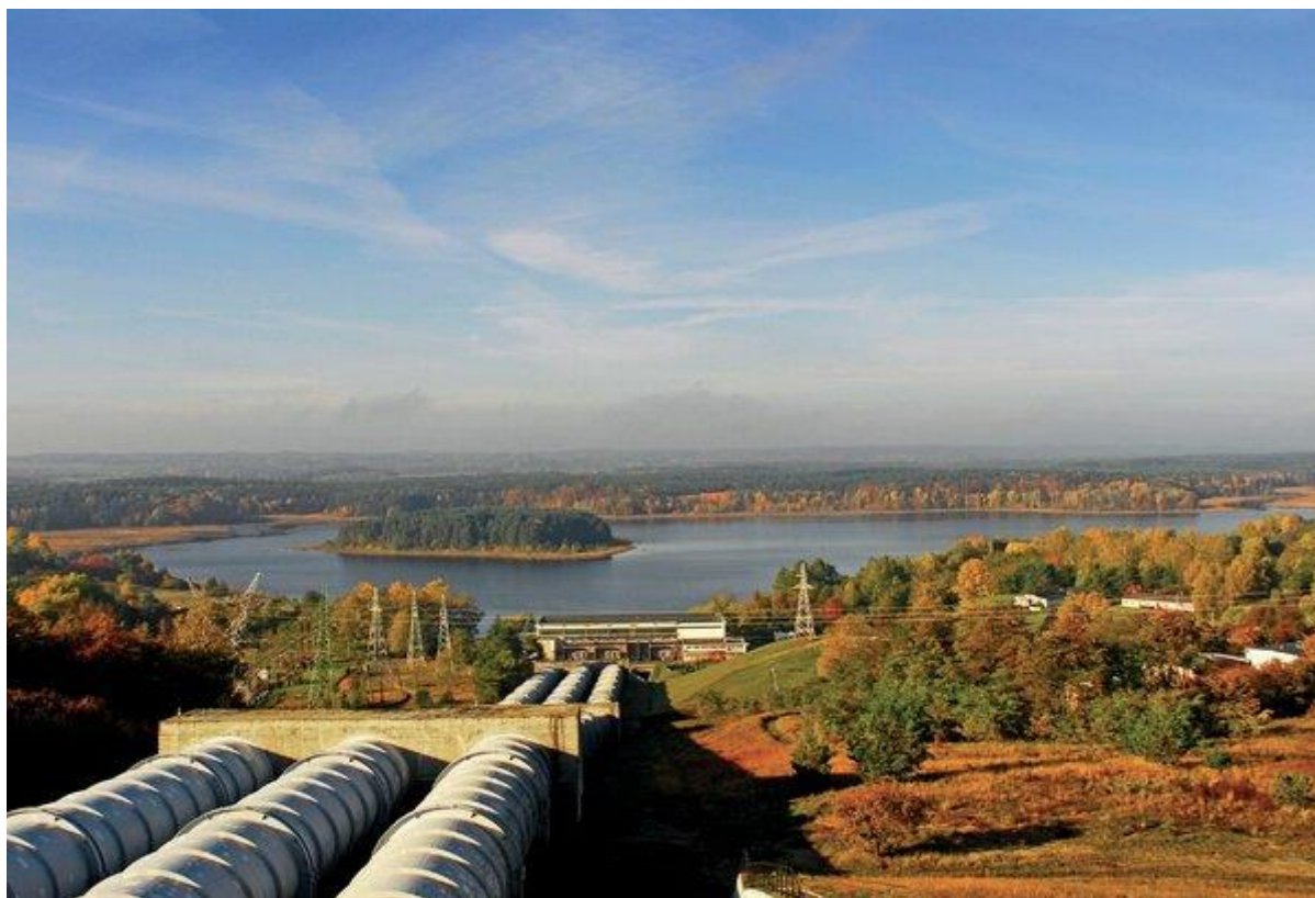
Elektrownia szczytowo-pompowa Żydowo
