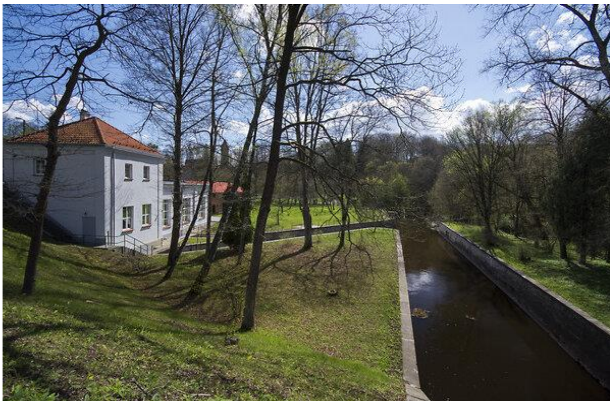
Elektrownia wodna Pieniężno
