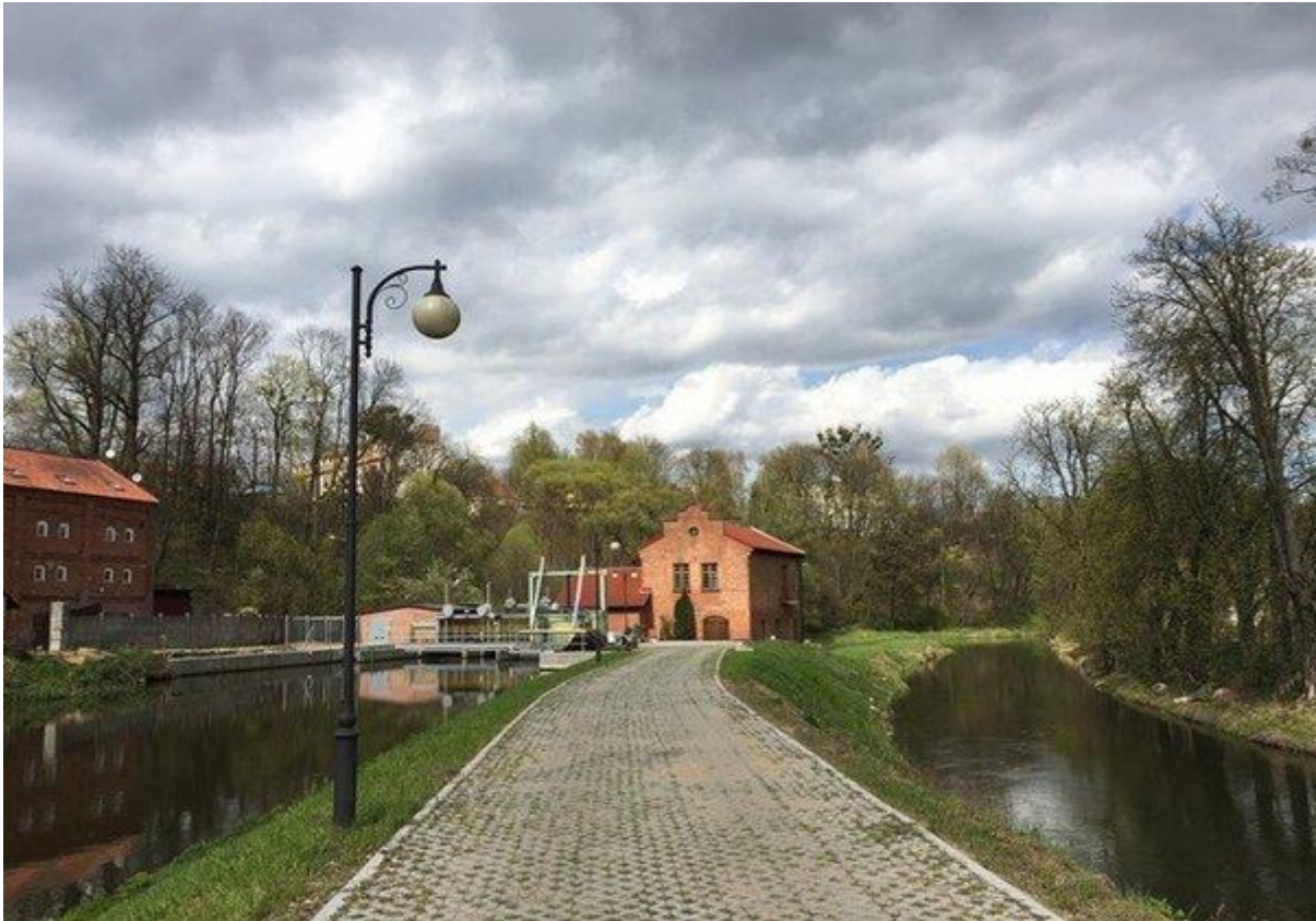
Elektrownia wodna Lidzbark
