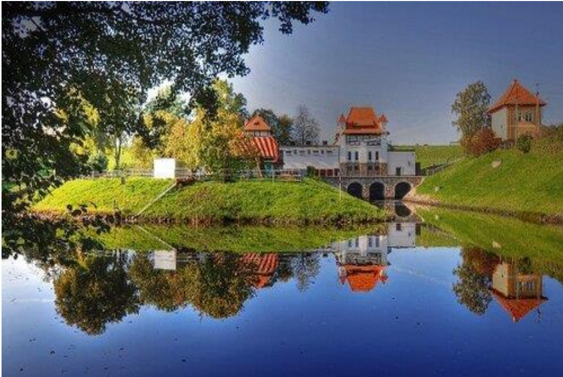
Elektrownia Wodna w Straszynie
