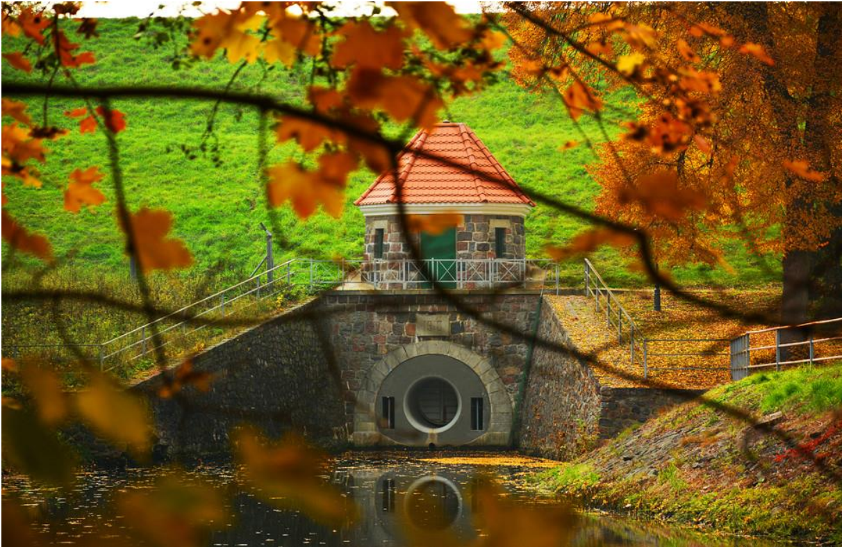
Elektrownia Wodna w Straszynie
